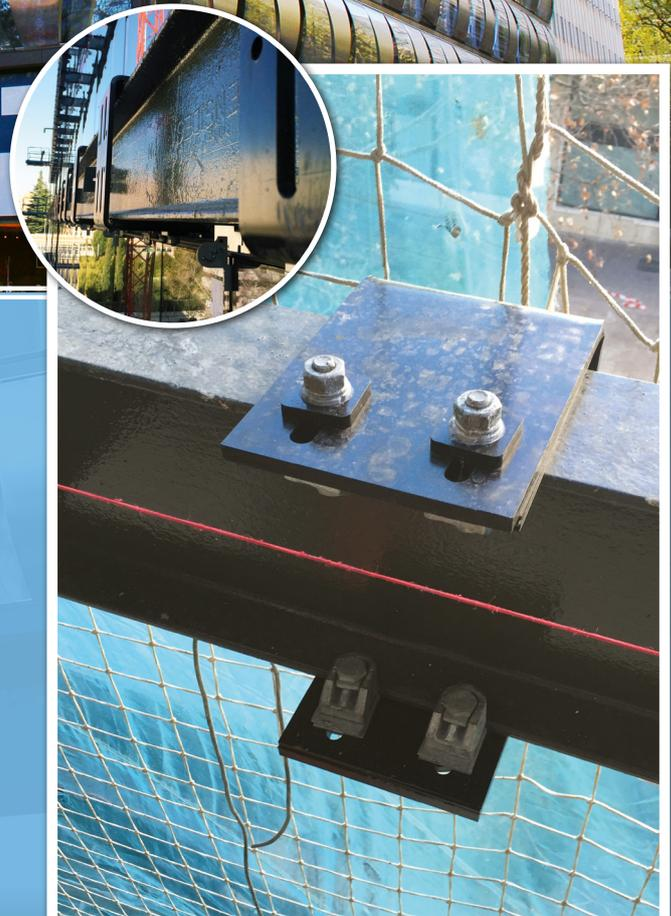
*Trägerklemmen Typ AF von Lindapter verbinden die C-förmigen Halterungen mit den Stahlprofilen des Gebäudeträgerwerks*
