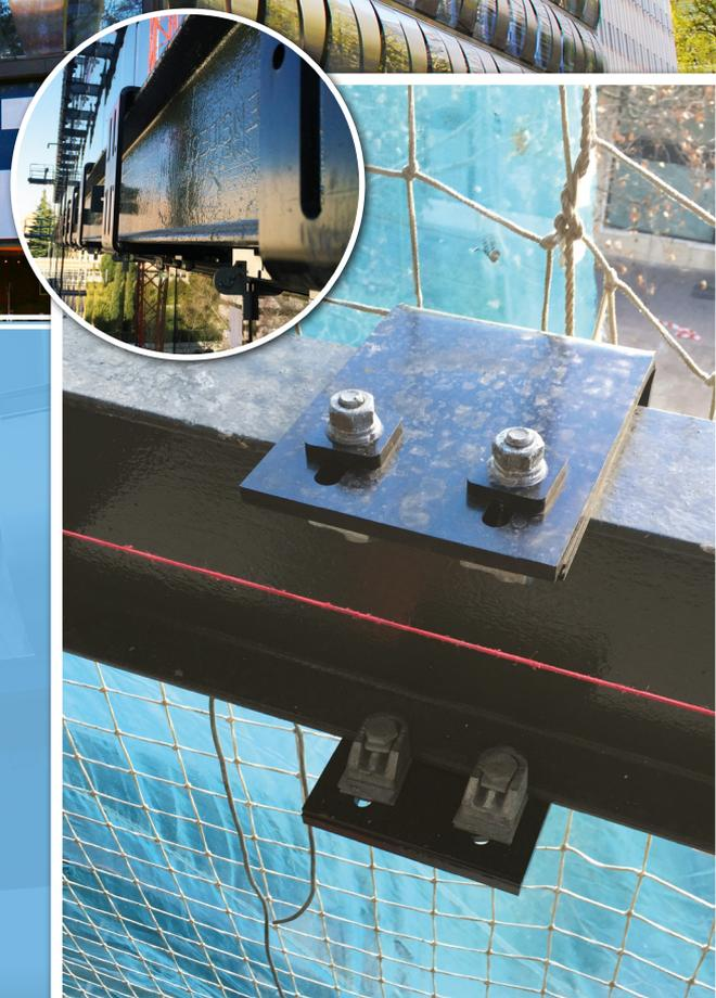
*Les crapauds de fixation Type AF de Lindapter relient les supports en C aux profilés métalliques de l'ouvrage principal*
