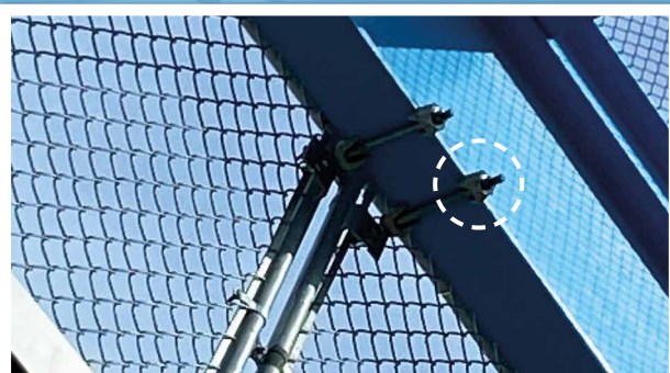
Mit Klemmen Typ CF und Gewindestangen montierte Flacheisen
