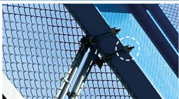
Les crapauds Type CF utilisés avec une tige filetée pour relier les sangles
