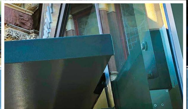
**Das Vordach wurde mit Hollo-Bolt über dem Eingang montiert**
