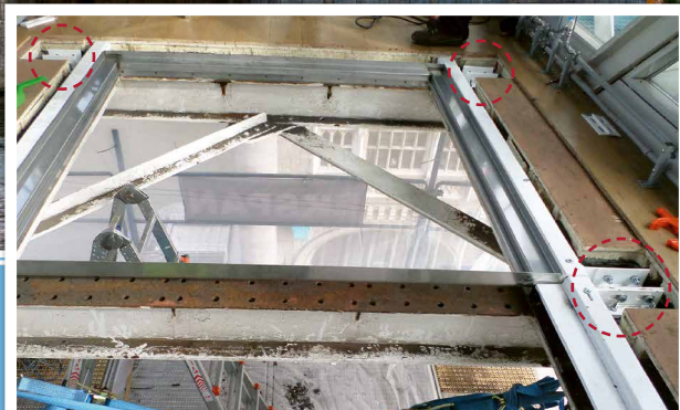
Die neue Unterkonstruktion wurde mit Halterungen an Stahllaschen montiert
