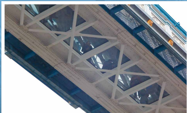
Das ursprüngliche Stahlgitterwerk wurde erhalten
