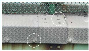
Les Hollo-Bolts ont fourni une solution durable pour les réparations de l'infrastructure et l'amélioration des passerelles de sécurité
