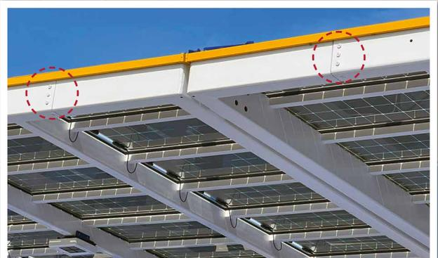
Solardachrahmen verbunden mit Hollo-Bolts
