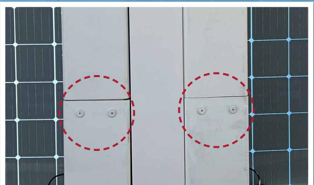
Hollo-Bolt (Senkkopf) installiert in einer Stoßverbindung
