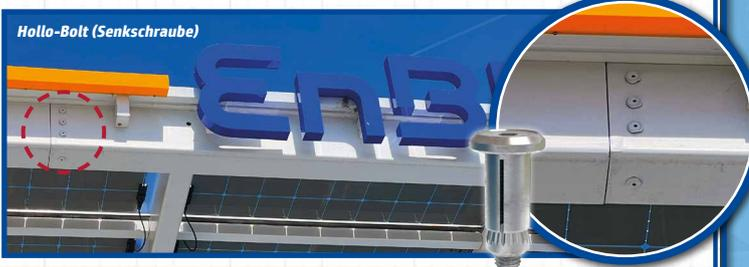
Im Projekt wurden alle Holo-Bolt Kopfausführungen verwendet, um die einzelnen Dachbauteile miteinander zu verbinden. In den Bereichen ohne bauliche Einschränkungen wurde die Sechskantkopfausführung verwendet. An Stellen mit Einschränkungen, wie zum Beispiel im Bereich der Solarmodule, wurden sowohl die Senkkopf- als auch die Flush-Fit-Ausführung verwendet. Die reduzierte Bauhöhe dieser beiden Varianten verhinderte Montageeinschränkungen bzw. konstruktive Kollisionen.
