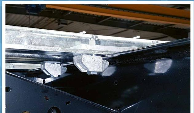
*Befestigung der Unterkonstruktion mit Klemmen Typ AF*
