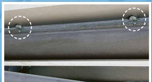
*FloorFast Grundkörper sicher geklemmt an die Stahlkonstruktion*
