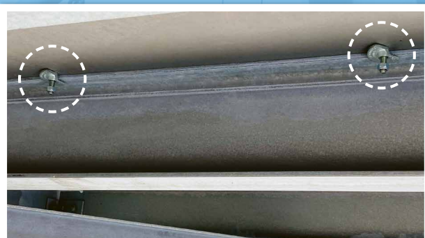
Le corps moulé en escalier du FloorFast permet de pincer fermement la structure support
