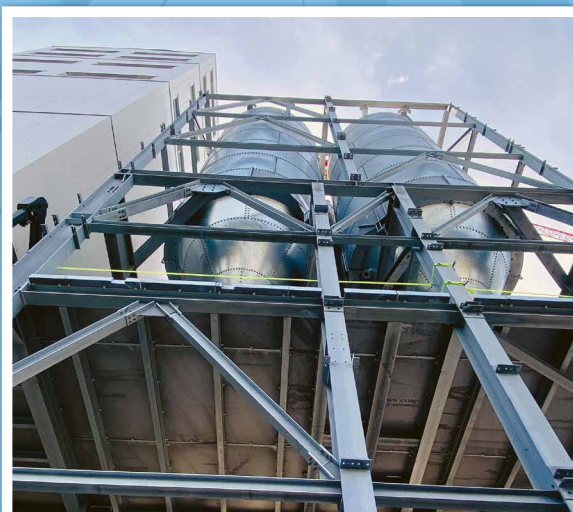
Les sept étages de la nouvelle tour et les silos ont été attachés au bâtiment existant
