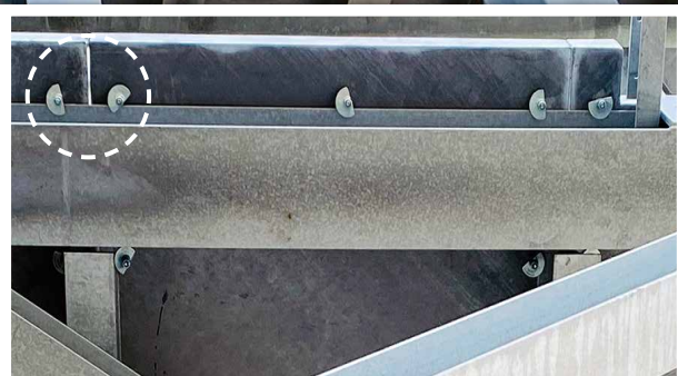
Le FloorFast installé sous le plancher fini
