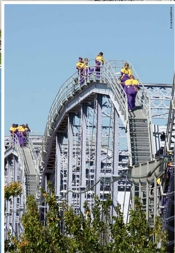
Der Wartungssteg wurde mit Trägerklemmen von Lindapter an der Brücke befestigt
