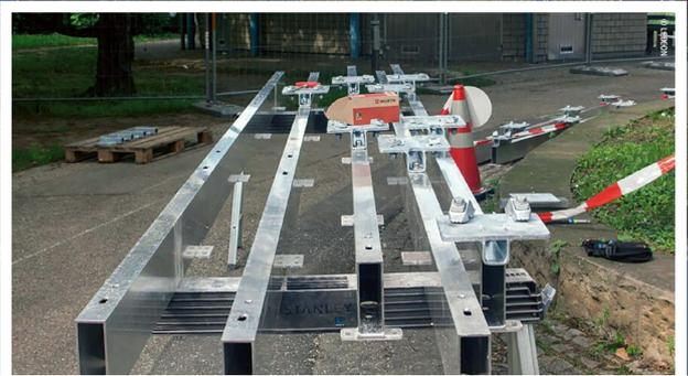
Die neue Unterkonstruktion wurde an die vorhandenen Stahlträger angepasst
