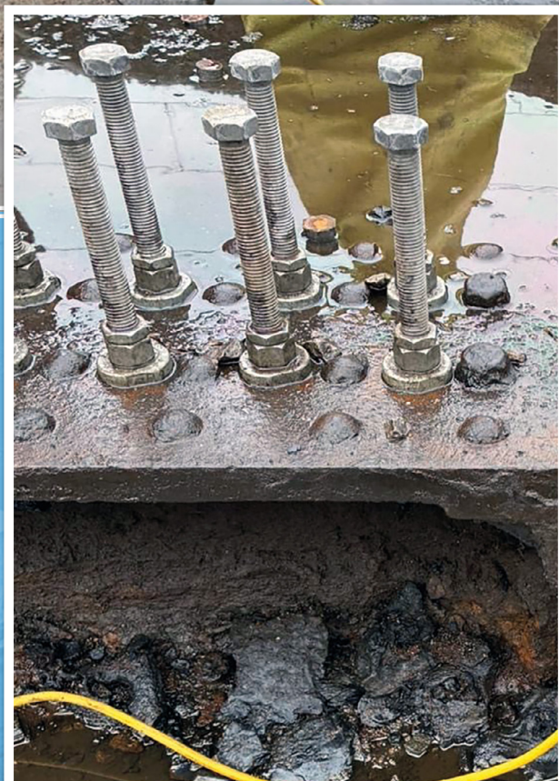
Les Hollo-Bolts de Lindapter ont été adaptés au moyen d'un modèle de boulon allongé pour obtenir un assemblage à goujon de cisaillement installé d'un seul côté
