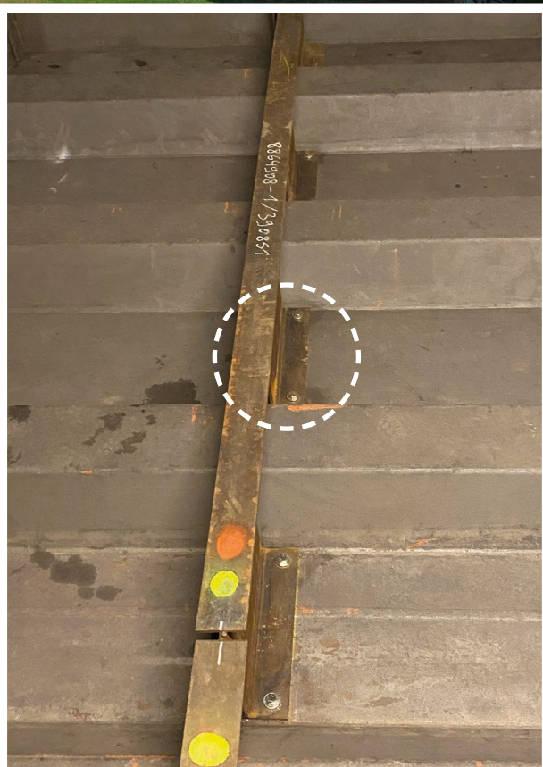
Mit Hollo-Bolt am Boden der Kastenprofile befestigte Stahlverstrebungen
