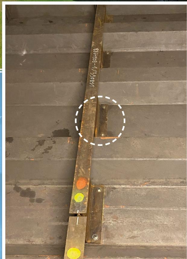
Cadres supports métalliques de renforcement reliés à la partie basse des caissons au moyen de Hollo-Bolts
