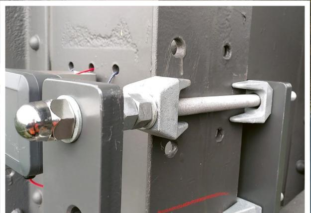
*Klemmen Typ CF boten eine zuverlässige, flexible Befestigungslösung für die Halterungen von Sicherheitsseilen*
