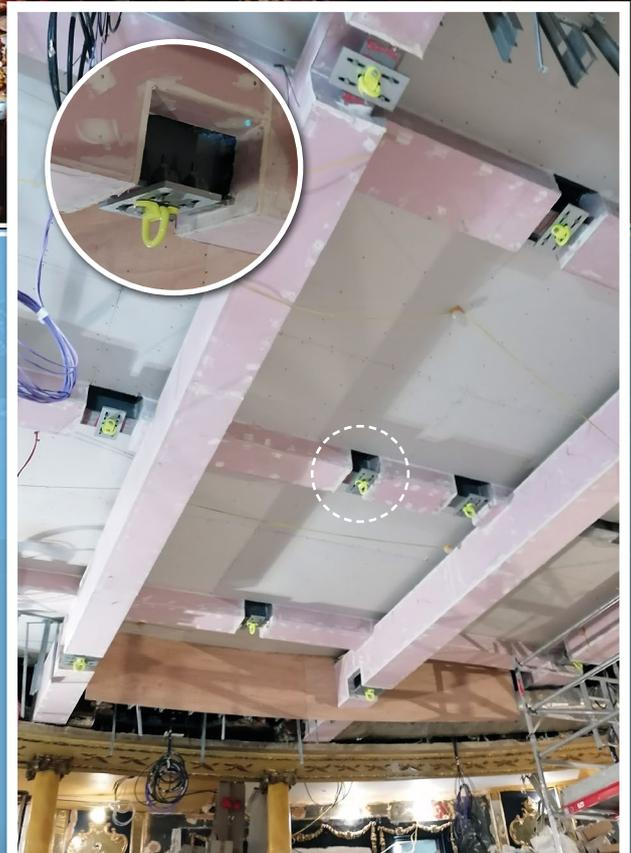
*Durch die verstellbaren Hebeösen von Lindapter blieb die vorhandene Bausubstanz intakt*
