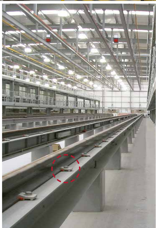
Die Schienen wurden mit Schienenklemmen Typ HD befestigt
