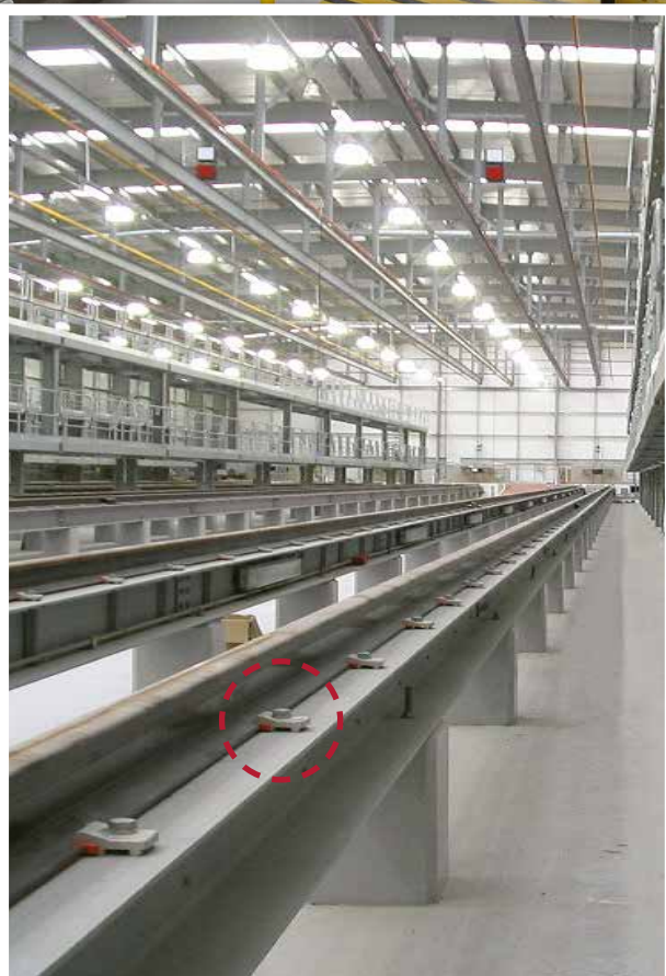
Les crapauds Type HD utilisés pour sécuriser les rails
