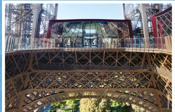
*Typ AF verbindet die Stahlprofile mit der ursprünglichen architektonischen Stahlkonstruktion ohne diese zu beschädigen.*
