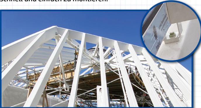
Die neuen Verglasungsrahmen wurden dann mit den Halterungen verbunden, bevor zum Abschluss der Montage die neuen Glasscheiben eingesetzt wurden.
