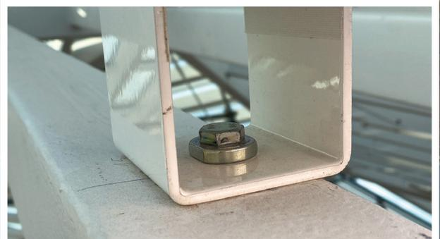
Die U-förmige Halterung wurde mit Hollo-Bolt am vorhandenen Hohlprofil montiert
