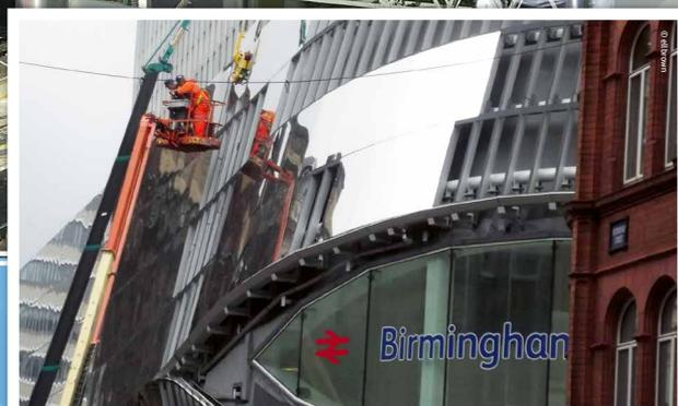
**Les Hollo-Bolts utilisés pour assembler les panneaux**
