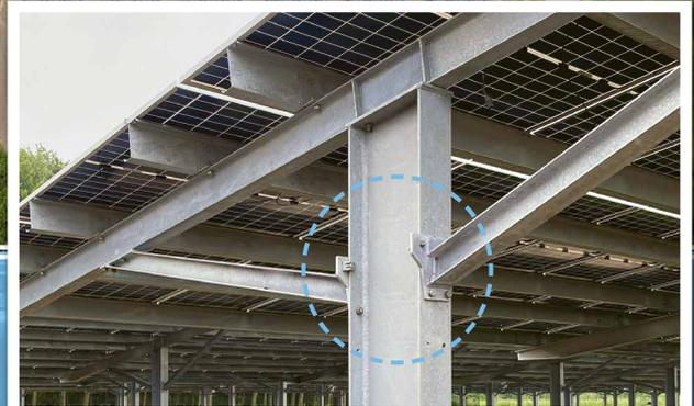
Die Lösung umfasste eine maßgeschneiderte Kopfplatte aus Stahl
