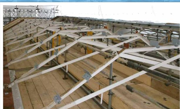
*Le système d'assemblage sans soudage a éliminé le travail à chaud sur place*
