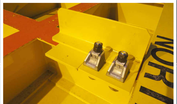
Trägerklemmen Typ AF zur Montage des Gestells
