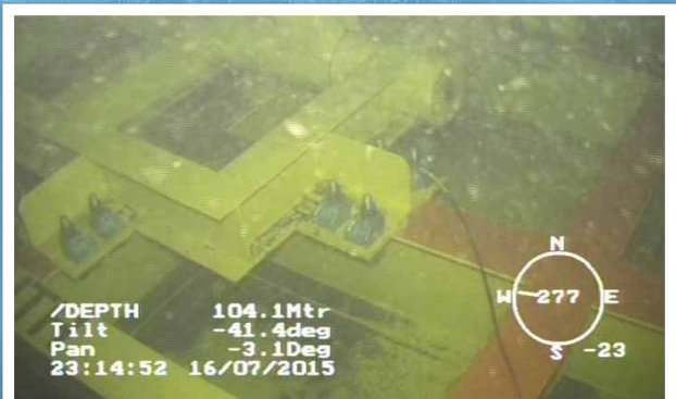
Grundgestell 104 m unter dem Meeresspiegel in Position
