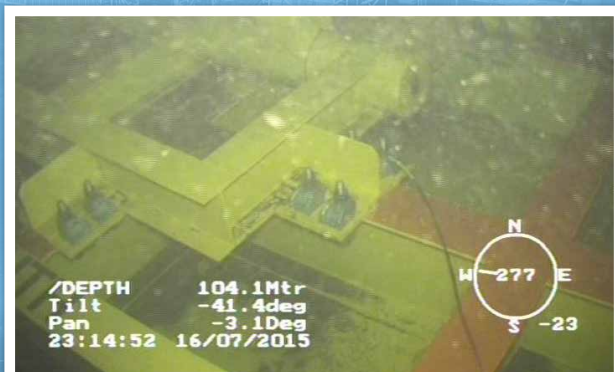
La structure de soutien en position au fond de la mer, à 104 m de profondeur
