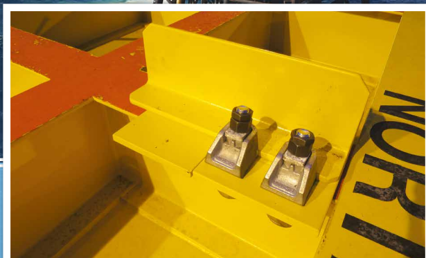
Les crapauds de fixation Type AF qui sécurisent la structure
