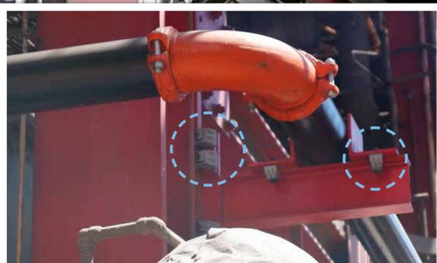
Les crapauds de fixation Type AAF utilisés pour résister aux efforts de traction et de glissement
