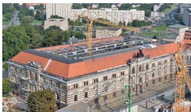
Bild 3. Der Neubau tritt auch in der Stadtsilhouette nicht in Erscheinung, da sich das Volumen genau zwischen First und Traufe des Altbaus befindet und damit die historische Firstlinie nicht überragt © Marcus Ebener
